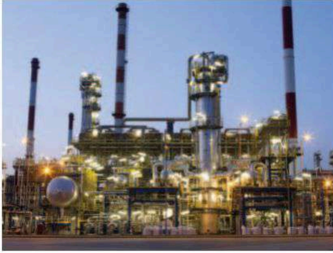
محطة توليد الكهرباء في الجبيل
